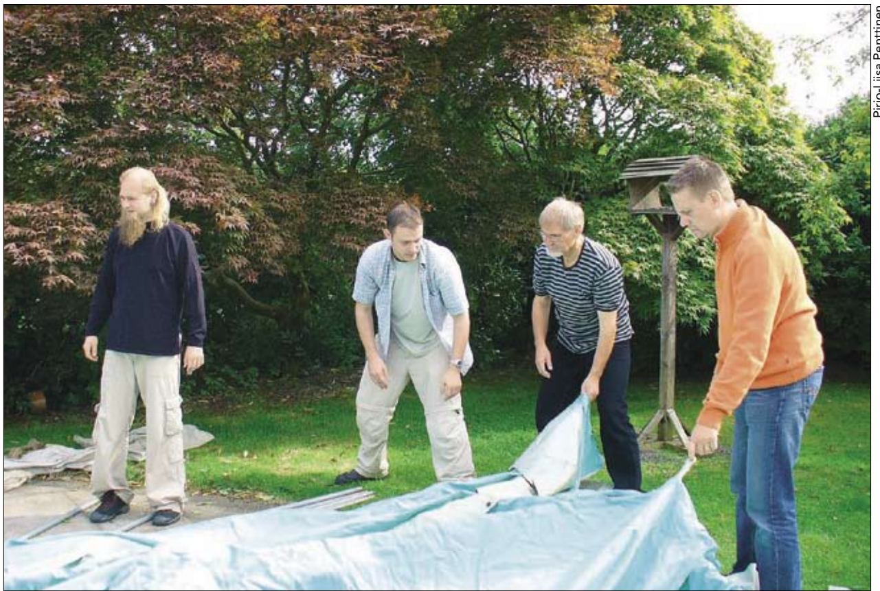
Miehet pystyttivät puutarhakatosta kauniina kesäpäivänä.
