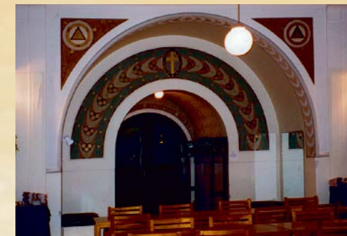
Lahden NNKY:n Jugend-Sali on entisöity ja peruskorjattu. Lisäksi NNKY hankki viereisen liikehuoneiston, josta tehtiin remontissa toimisto- ja kokoustila. Yhdistys osti huoneiston Vapaudenkatu 8:sta vuonna 1928.
